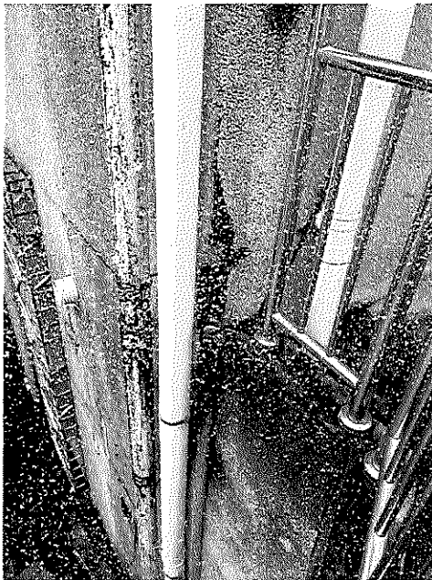
柱钢筋外露及锈蚀检测照片
