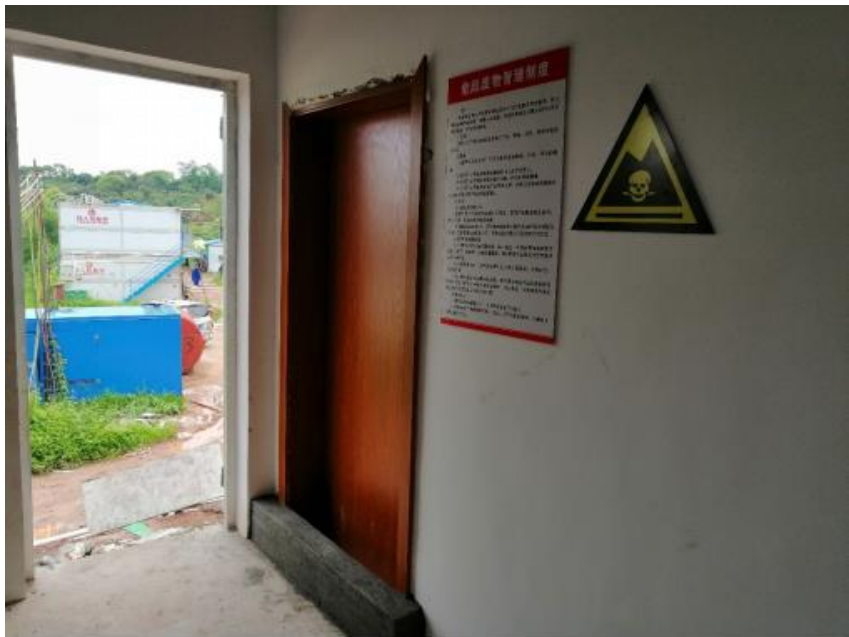
图 3.7-11 危废临时仓库外部
